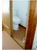
↑トイレ工事後
