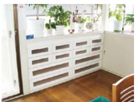
家具収納工事 ダイニングの引き違い戸の収納を引き出し収納へ取り替え。多くの食器を入れることができました。
