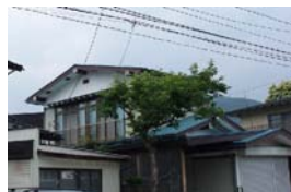
屋根の塗替え工事 ブルーの屋根がこげ茶色に変身
